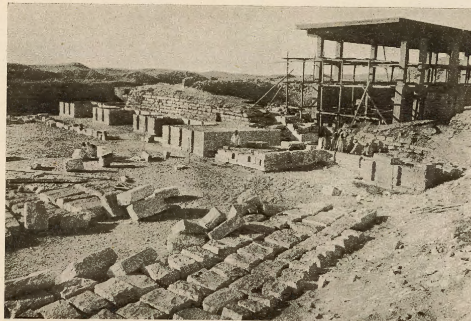
1. — Commencement de la restauration de l'entrée de l'enceinte de la Pyramide à degrés par Abd Es-Salam M. Hussein Eff. (décembre 1941).
